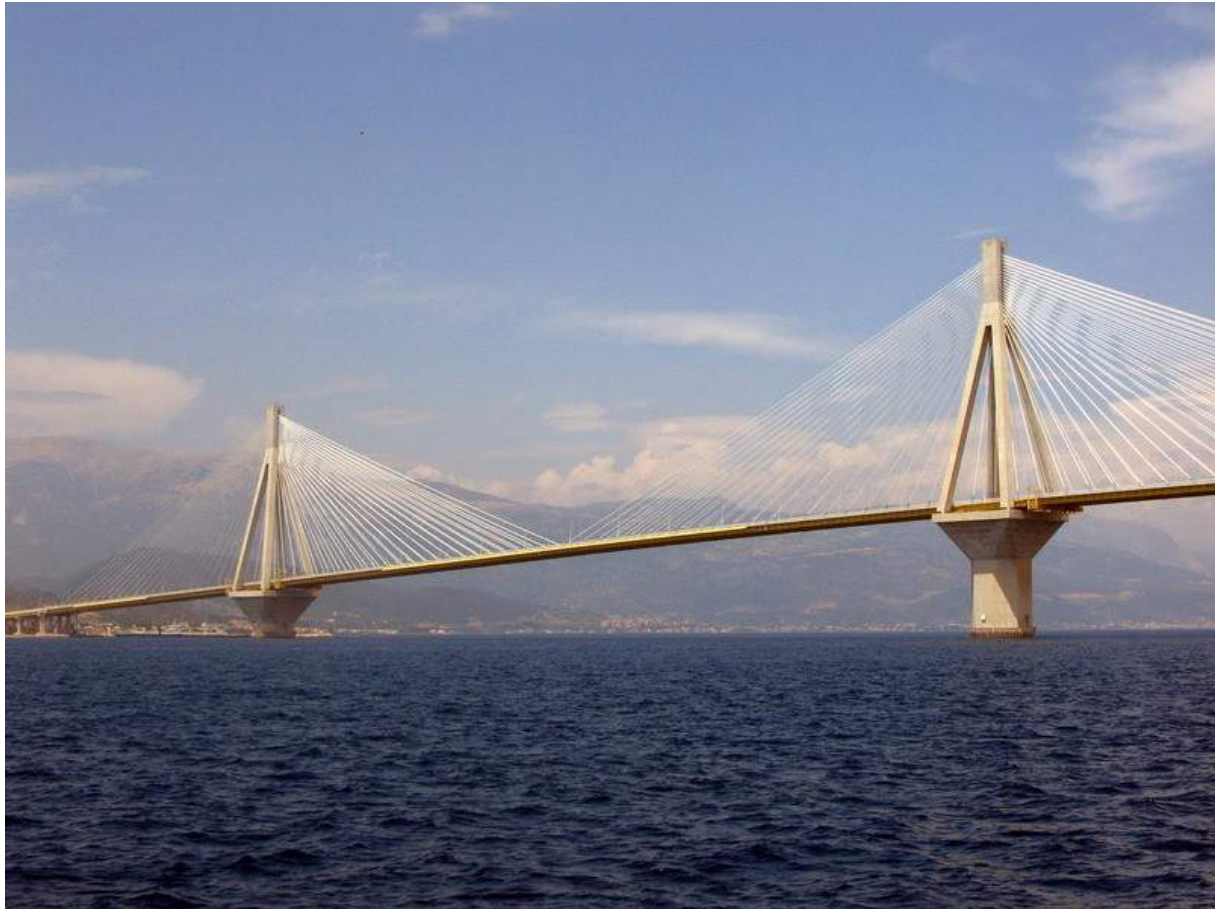
Pont de Rion
