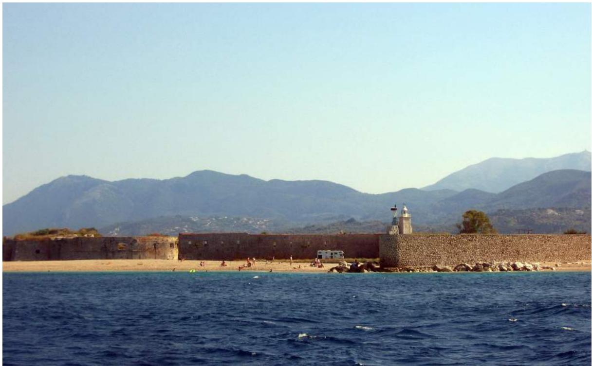
Entrée nord du canal de Lefkas
